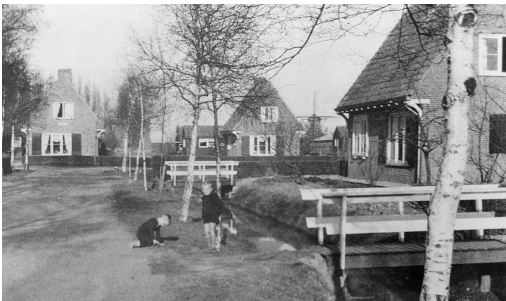
Foto uit 1948 vanuit Berkenlaan op Jac.P. Thijsselaan. Aan de rechterzijde is een brugje over de sloot zichtbaar
