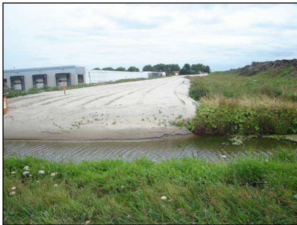
Afbeelding: aanlegwerkzaamheden N201
