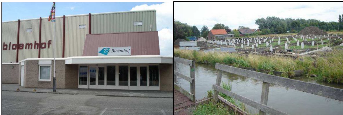
Afbeelding: sporthal De Bloemhof (links) en bouwwerkzaamheden ter plaatse van het inmiddels in gebruik genomen gebouw op de hoek Zwanenpad-Machineweg (rechts)
