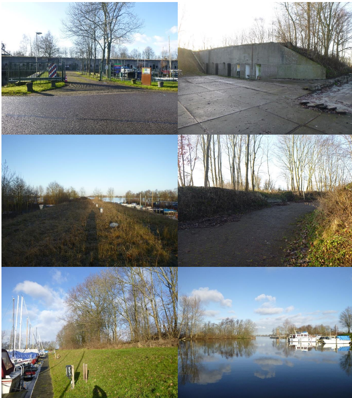
Figuur 2-2. Huidige situatie fort. Linksboven de ingang van het fort; rechtsboven het frontgebouw met begroeid talud; linksmidden het dak; rechtsmidden de binnenzijde van de muur voor het frontgebouw; linksonder de buitenzijde van de muur; rechtsonder de omringende wal met opening naar de Westeinderplassen.
