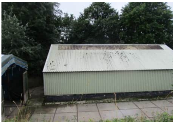
Figuur 13 Gesloopte loods en overkapping voor stalling van boten
