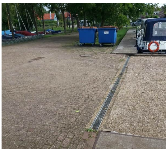
Figuur 7 Goot langs de betonplaat afspuitplaats
