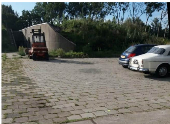
Figuur 14 Tegelverharding gesloopte loods C
