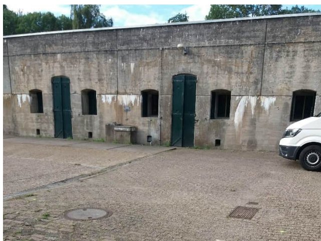
Figuur 8 Overgang betonnen plaat van de afspuitplaats naar stelcon
