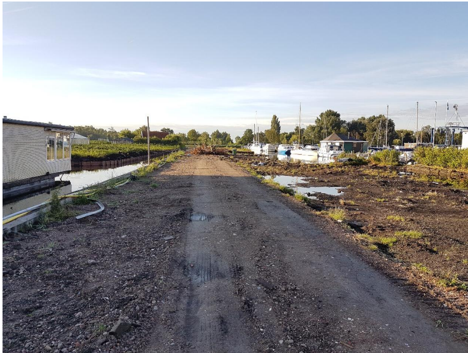
Foto 1: overzicht en bouwweg
