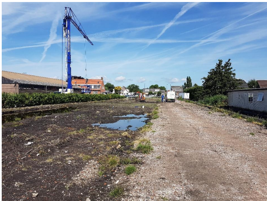
Foto 2: overzicht en bouwweg
