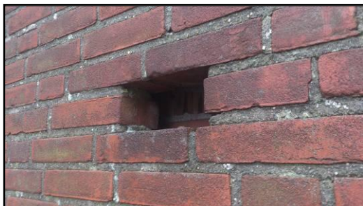
Foto 5: Gat in spouwmuur
