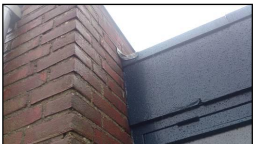
Foto 9: Loodlap met opening eronder
