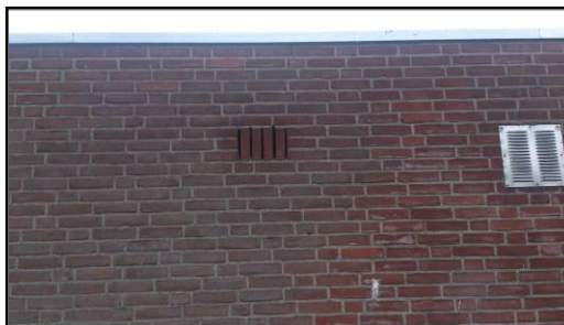
Foto 6: Ventilatiegaten in spouwmuur
