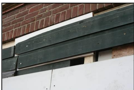
Foto 15: Stukke ramen afgedicht met houten platen
