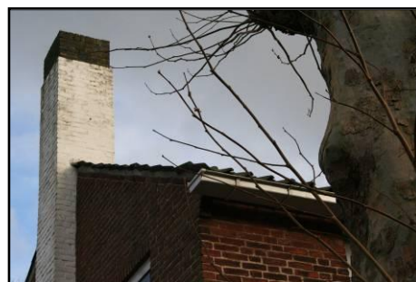
Foto 10: Schoorsteen, loodflap en dakpannen
