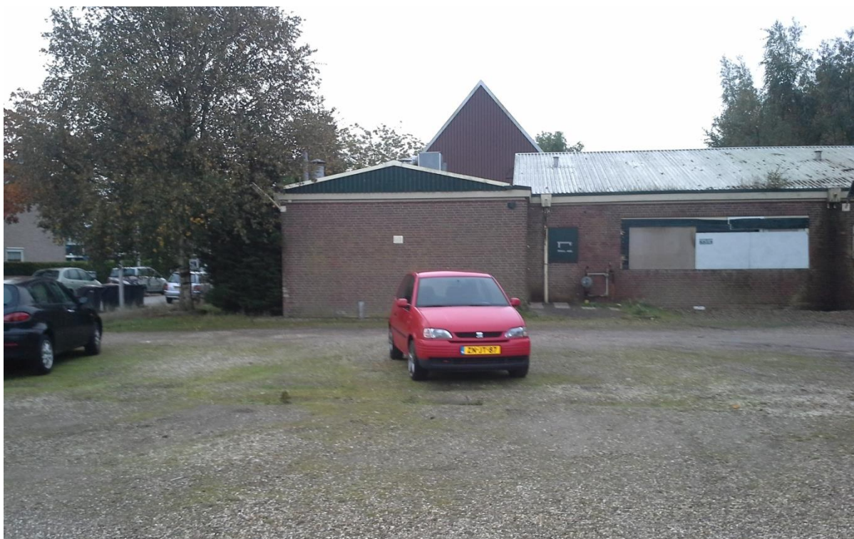
Foto 1: Zicht vanuit noordwestzijde op het verenigingsgebouw.
