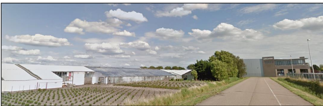
Figuur 5: voormalige kassen en bedrijfsgebouwen, gezien vanaf de Hollandweg (bron: www.google.nl/maps )
