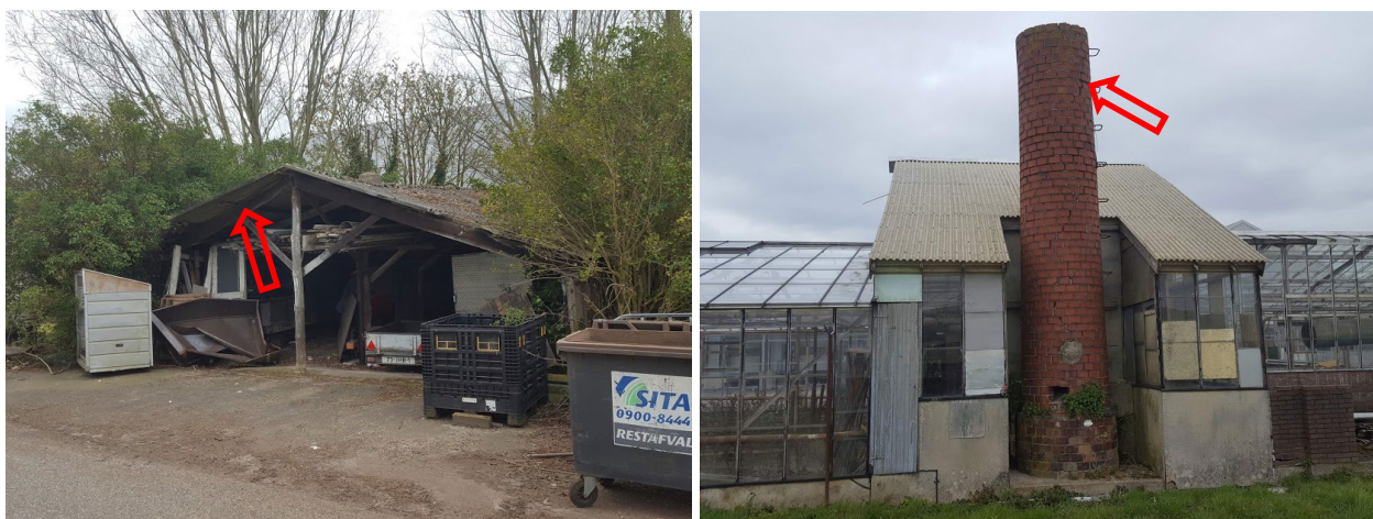
Figuur 8. Door wegkruipruimtes in de constructie van de schuur (foto links, zie rode pijl) en open voegen in de schoorsteen (foto rechts, zie rode pijl) zijn relatief kleine verblijfsmogelijkheden voor vleermuizen aanwezig.
