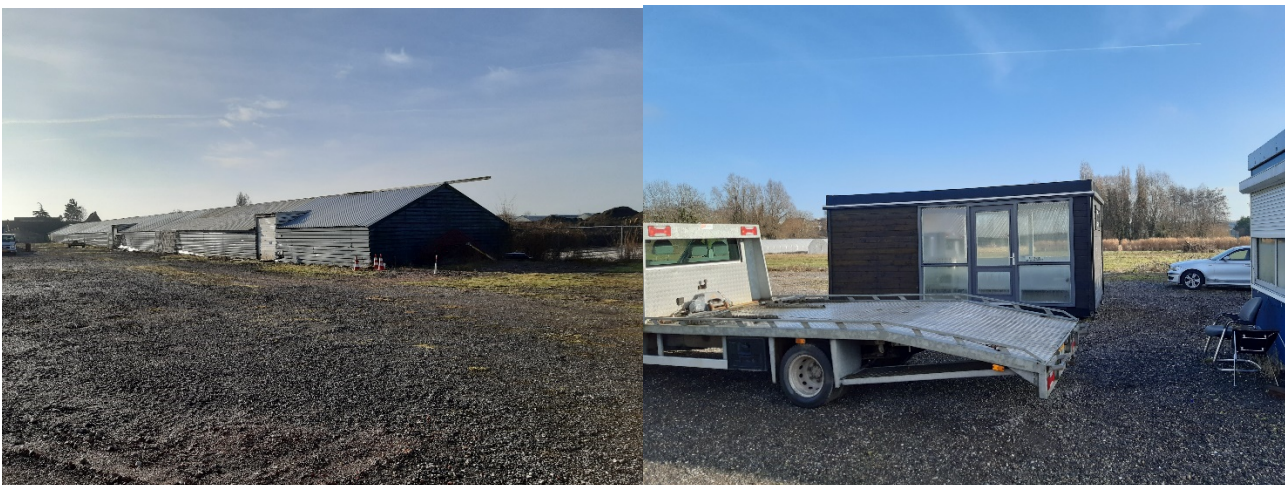
Figuur 18. Foto-impressie projectgebied. Foto links: Parkeerplaats en stalen schuur waar potentiële verblijfplaatsen van broedvogels en vleermuizen ontbreken. Foto rechts: Bouwkeet waar potentiële verblijfplaatsen van broedvogels en vleermuizen ontbreken.
