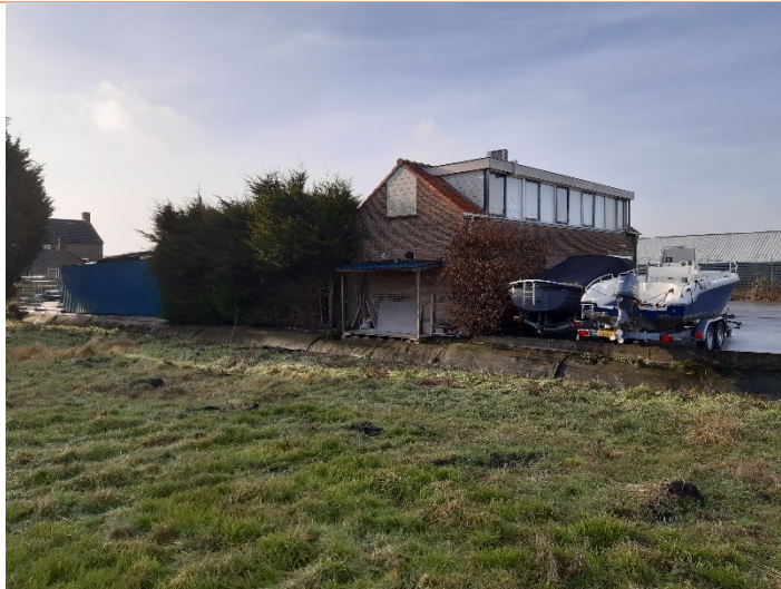
Figuur 5. Gebouw binnen projectgebied vormt een potentiële nestplaats van huismus. In de struiken zijn roepende huismussen waargenomen.
