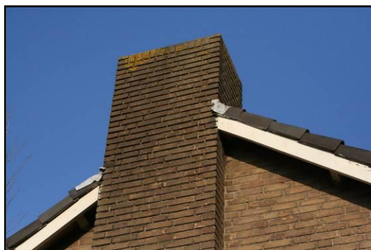
Foto 10: Stenen schoorsteen op de woning met loodflappen
