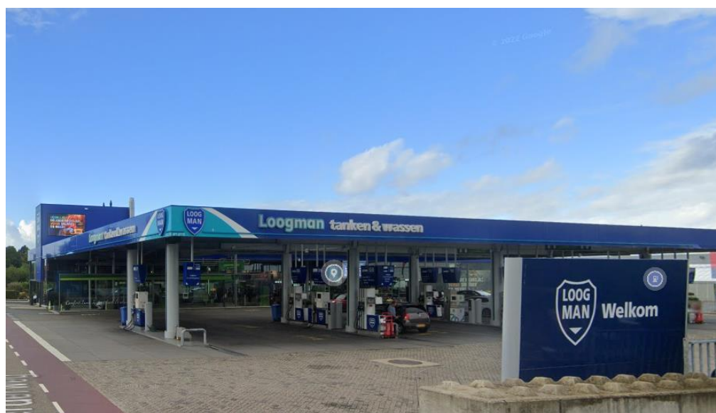
figuur 5 Overkapping tankplaats
