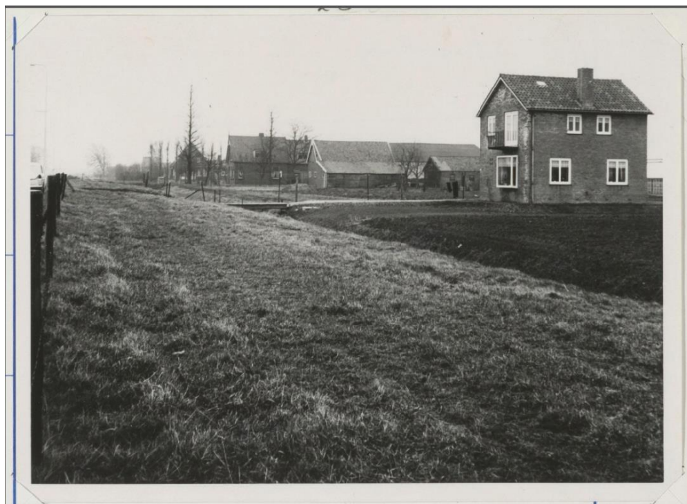
Figuur 17. Het plangebied in oostelijke richting ter hoogte van Aalsmeerderweg nr. 340 omstreeks 1980. Links de autoweg, op de voorgrond het spoortracé na het opruimen van de rails in 1975. Hier is later een fietspad aangelegd (Noord-Hollands Archief).
