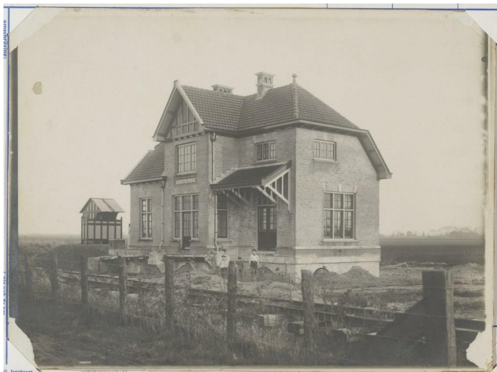
Figuur 16. Halte Oostende tijdens de bouw omstreeks 1910. Op de voorgrond de spoorrails, op de achtergrond de uitgestrekte Oosteinderpoelpolder (Noord-Hollands Archief).
