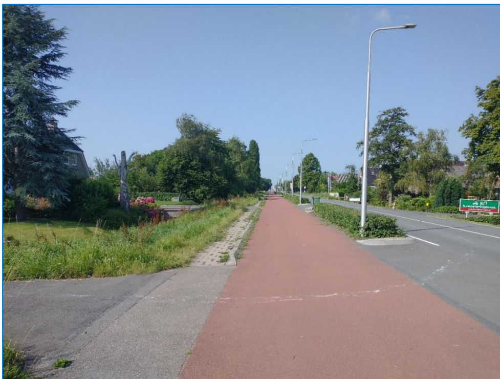
Figuur 22. Huidig profiel van de zuidkant van de Aalsmeerderweg: v.r.n.l. de verbrede en verharde autoweg, het fietspad op de plek van het spoortracé, sloot, voortuinen, woningen (met soms daarachter nog een kwekerij) (foto: RAAP, 4-8-2021).
