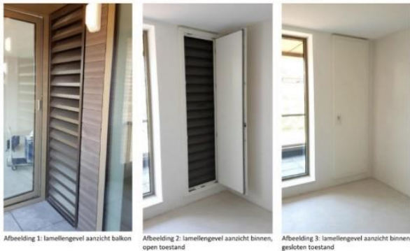
Figuur 5b: Principe geluidwerend louvre (Comfortbox) aan de binnenzijde afsluitbaar
