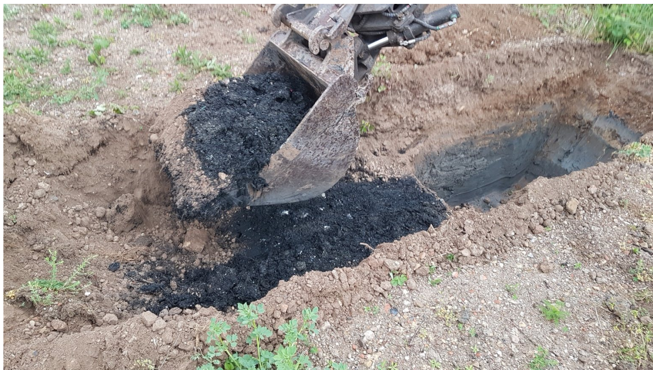
Foto 2: duidelijk waarneembare sterk verontreinigde sintelhoudende bodemlaag onder Puinfunderingslaag (met daaronder schone kleigrond)
