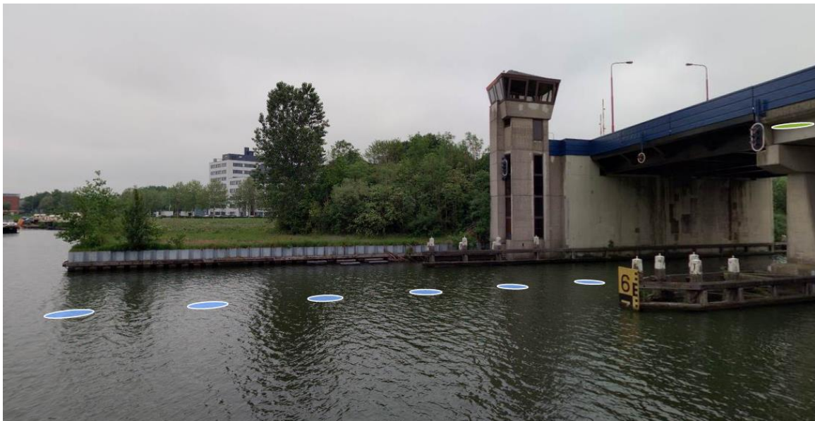
Afbeelding 1.3 Aanzicht damwand en brug (bron: cyclomedia)
