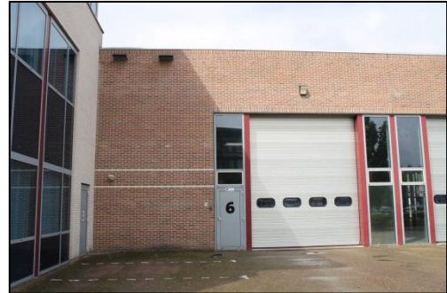
De noordaanzijde van het kantorengedouw.
