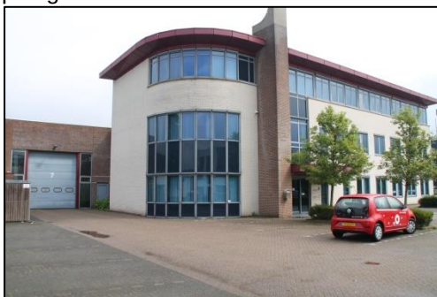
De zuidzijde van het kantoorgebouw
