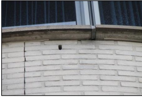
Aanwezige stootvoegen en kieren in het kantoorgebouw.
