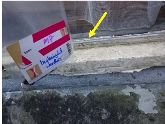
Foto 6: Beglazingskit in kozijnwerk van het woonhuis (niet asbesthoudend / zie M-6 + M-7)
