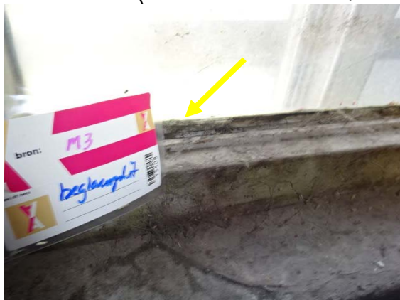
Foto 2: Beglazingskit in kozijnwerk van loods 4 (niet asbesthoudend / zie M-3)
