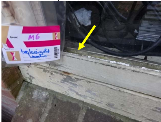
Foto 6: Beglazingskit in kozijnwerk van het woonhuis (niet asbesthoudend / zie M-6 + M-7)
