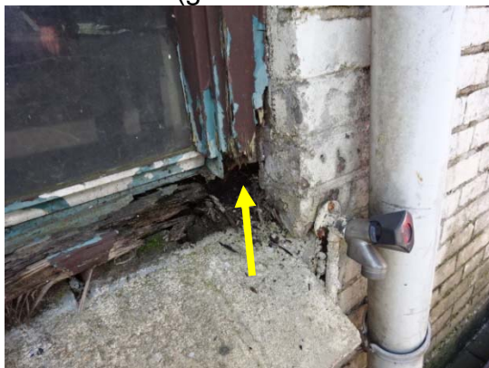
Foto 7: Checkpunt in muur naast kozijnwerk (geen asbestverdachte materialen aangetroffen)
