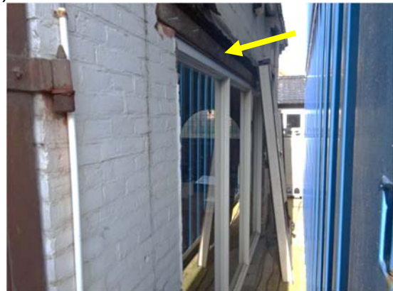
Foto 4: Bitumen langs kozijnbalk bij de woonkamer van het woonhuis (niet asbesthoudend / zie M-5)
