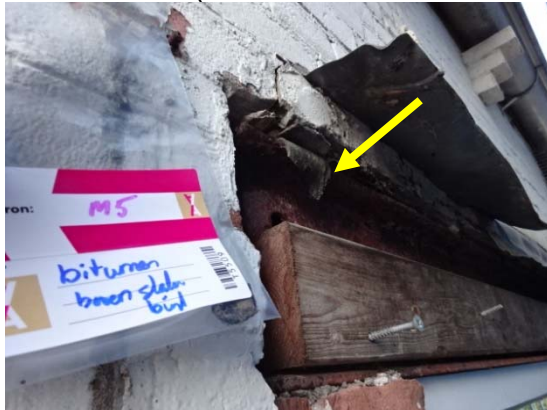
Foto 4: Bitumen langs kozijnbalk bij de woonkamer van het woonhuis (niet asbesthoudend / zie M-5)
