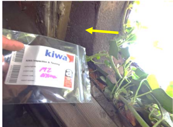
Foto 1: Bitumen tussen hout dakbeschot + dakpannen van loods 4 (niet asbesthoudend / zie M-1 + M-2)
