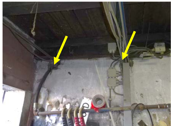
Foto 3: Koord / touw in muurdoorvoeren van loods 4 (niet asbesthoudend / zie M-4)
