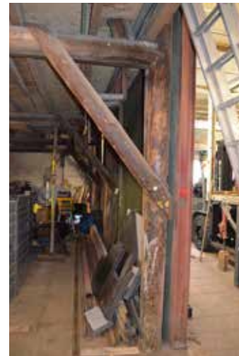
16 Halfhoutse verbindingen op het spant.
