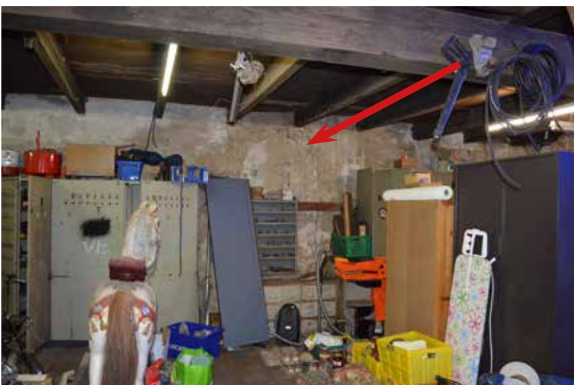
14 In de stenen schuur/ werkplaats zijn twee dichtgezette vensters met rondboog aanwezig (rode pijl).
