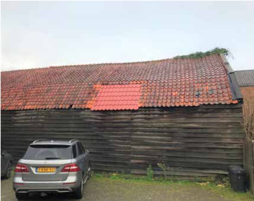
12 Achterzijde van de houten schuur met gepotdekselde delen en mansardekap.
