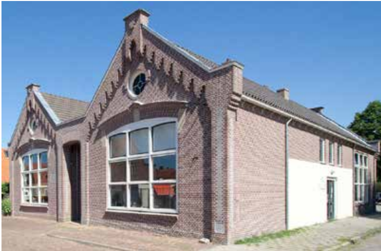
4 De school uit 1883 ligt tegenover het perceel B 1419 aan de rechterzijde van de Schoolstraat. .
