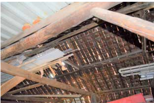
17 Kapconstructie schuur met rondhout en geschaafd hout.
