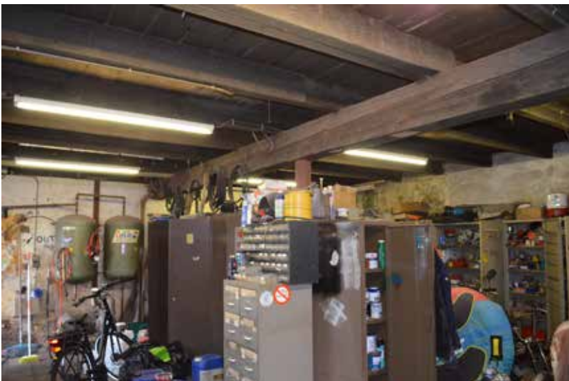
13 Interieur stenen schuur/ werkplaats met ondersteunende balk op gemetselde poer.
