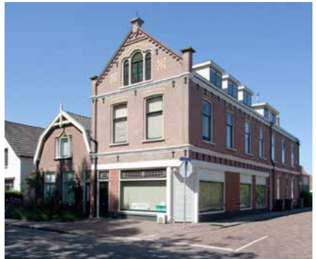
5 Het hoekpand Herenstraat 51/Schoolstraat 1-3 ligt met de lange zijgevel aan de Schoolstraat.
