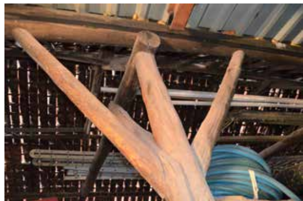
18 Spantbeen met windschoren van rondhout in de kapconstructie schuur.
