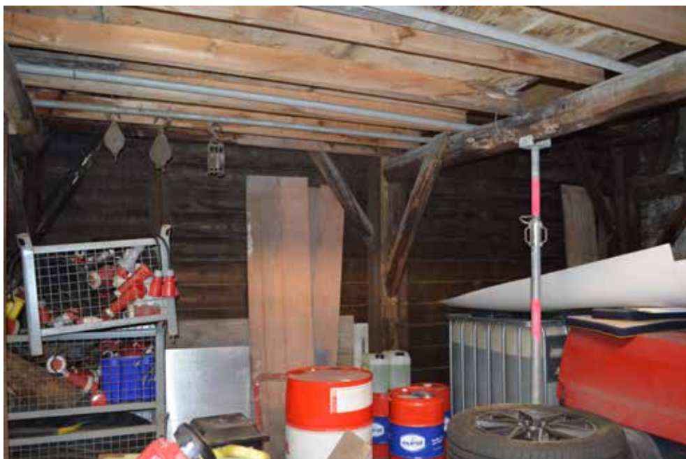
21 Interieur houten schuur met spant van rondhout. De gepotdekselde delen van de buitenwand zijn in 1983 vernieuwd.
