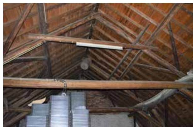
20 Kapconstructie stenen schuur met spant en haan-hout van rondhout.
