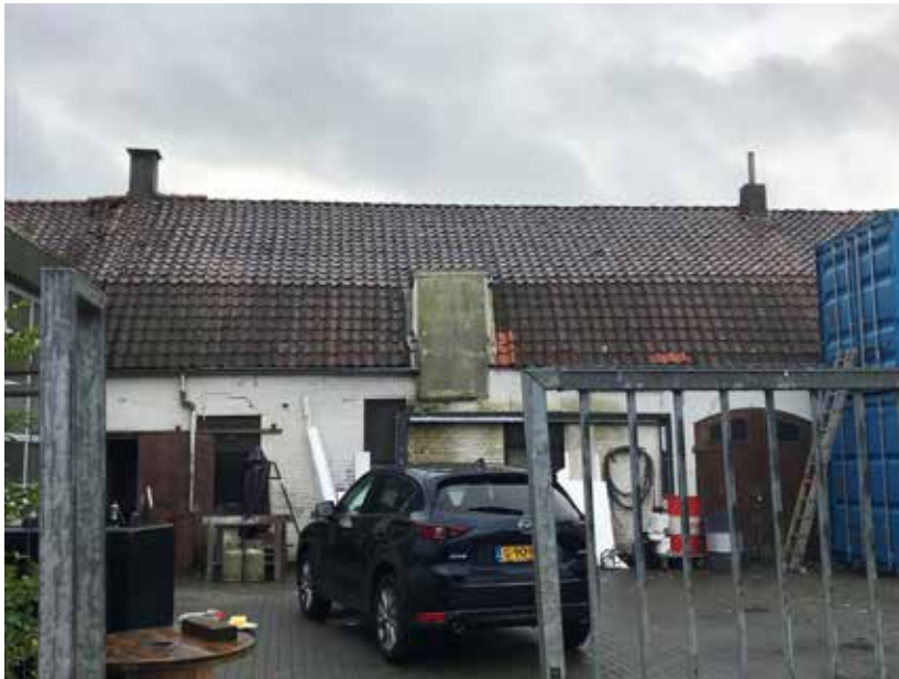
9 Gevel straatzijde met hooi- of hijsluik en dubbele deur naar de stenen schuur/werkplaats.
