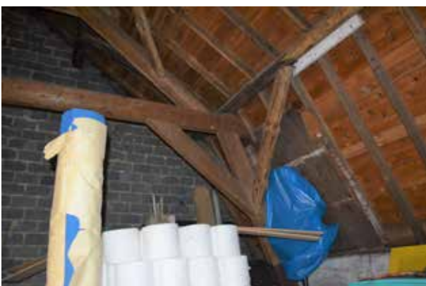
19 Kapconstructie stenen schuur met spanten van geschaafd hout en rondhouten windschoren.
