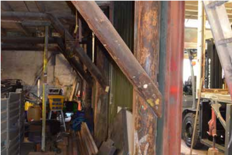
15 Interieur houten schuur vanaf de zijde van de loods met spanten van rondhout.
