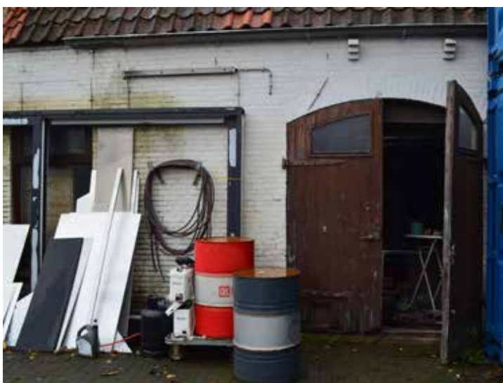
10 Dubbele deur naar stenen schuur/werkplaats.
