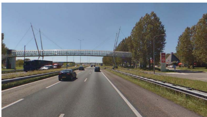
Figuur 3.6: Voetgangersbrug tussen beide verzorgingsplaatsen
