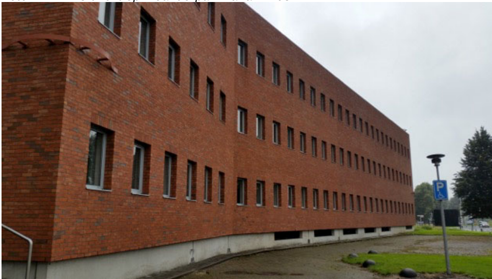
Foto 2 Buitenmuur Meanderpark waarin balkondeuren worden gesitueerd.
