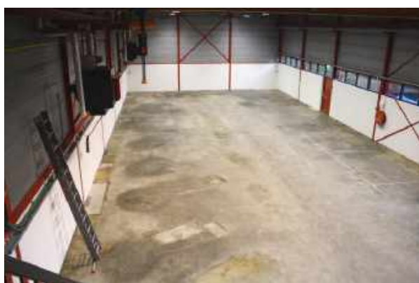
Kruyderlaan 1, hal 2, situatie juni 2010 na verwijdering laser snijmachines.
