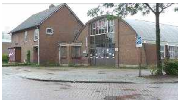
Hildo Kropstraat 35 (leegstaande woning) en 35a (leegstaande hal 1).
