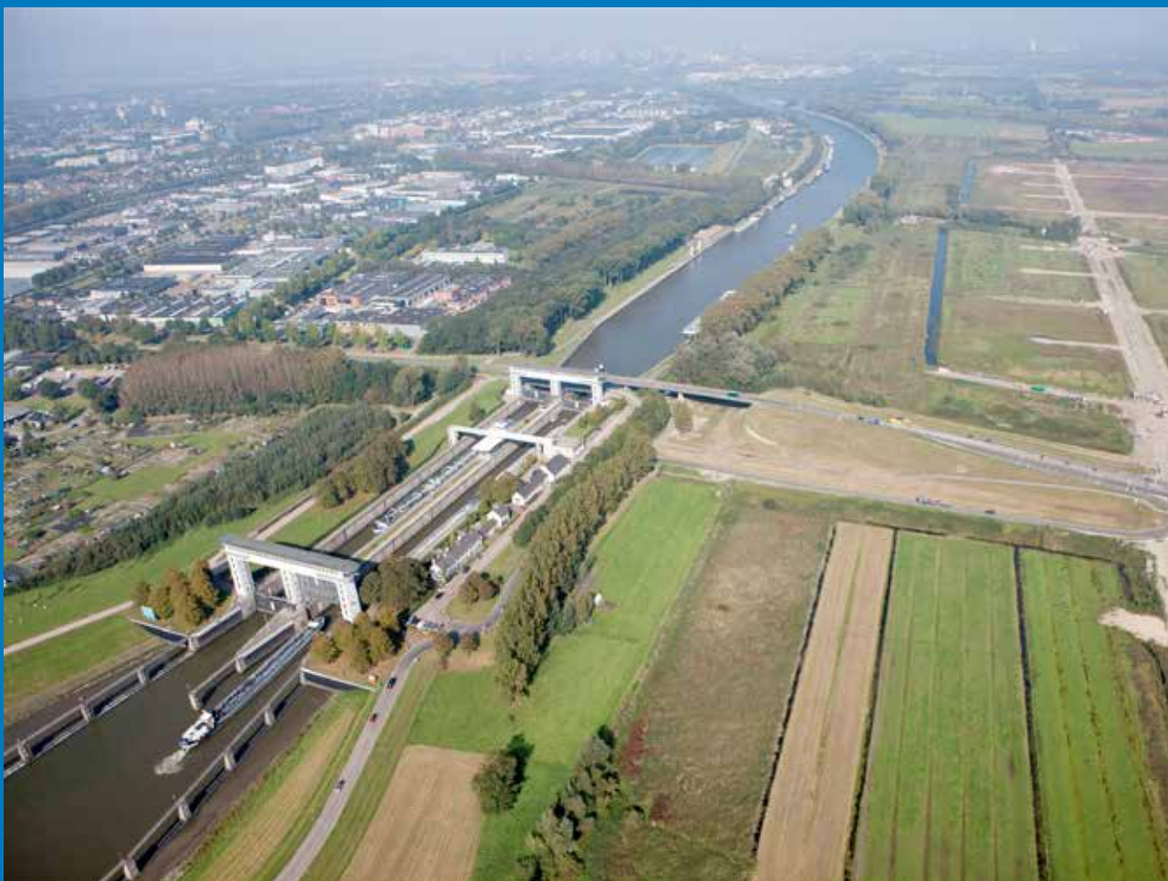
Zicht op het Lekkanaal met op de voorgrond de Prinses Beatrixsluis en de aanleg van bedrijvenpark Het Klooster. [luchtfoto: Rijkswaterstaat]
