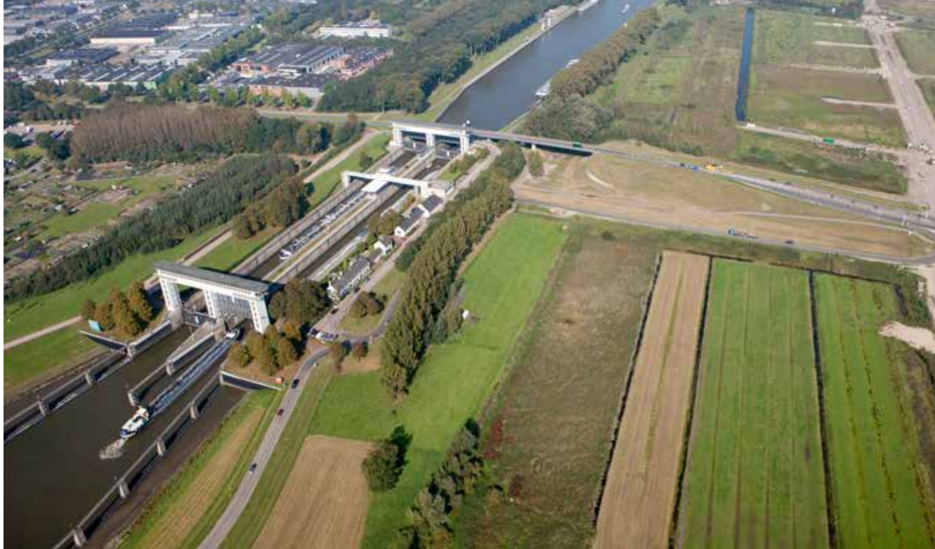
Luchtfoto van de Prinses Beatrixsluis met huidige kolken
