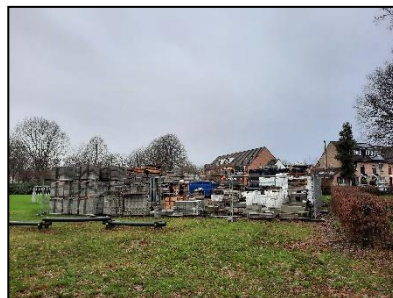
Figuur 7. Bouwwerkzaamheden in het centrum van de onderzoekslocatie.
