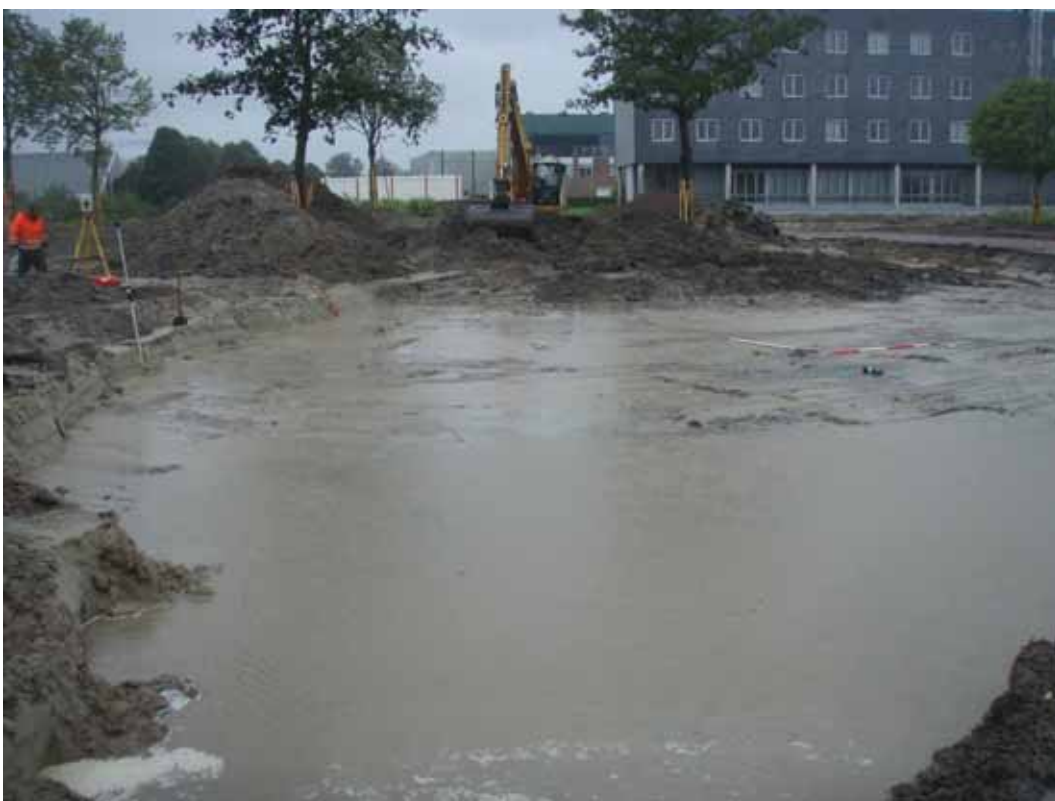
Afb. 14. Overzicht van vlak 1 in werkput 8, gezien vanuit het noorden.
