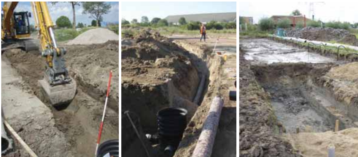
Afb. 3. (Links) uitgraven van drainagesleuven met V-vormige bak. (Midden) plaatsen van drainagebuizen en putten. (Rechts) uitgraven van riolering in wegtracé: vlak 1 ligt over de breedte van het cunet, vlak 2 is het verspringend niveau in de sleuf, vlak 3 is de bodem van het riool.
