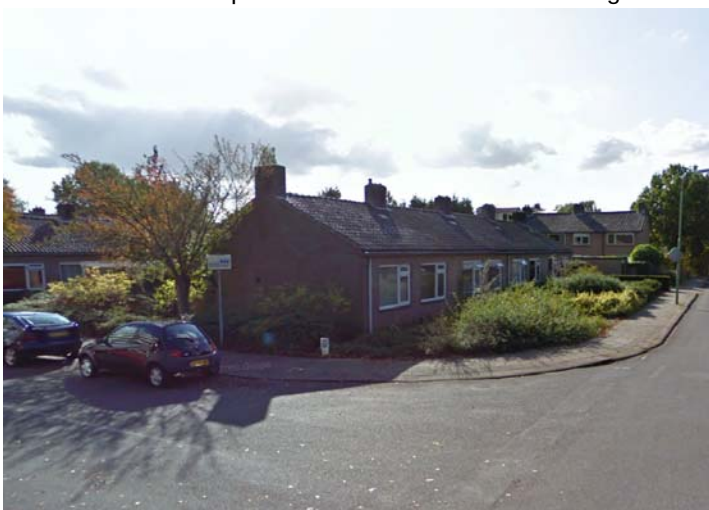
De bestaande woningen in het plangebied
