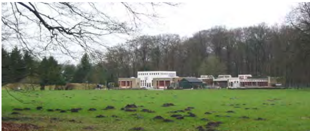
Basisschool gezien vanaf de zuidzijde
