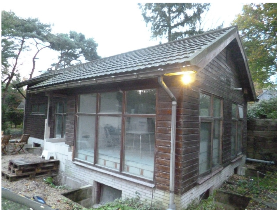
Figuur 4 Woning opgetrokken uit kalkzandsteen en hout met een dak van aluminiumplaten
