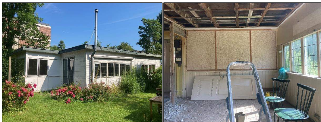
Figuur 2.5 (links): De zuidzijde van het gebouw, hier bestaat de muur deels uit hout en deels uit trespaplaten. Aan deze zijde bevinden zich struiken en planten direct naast het gebouw; Figuur 2.6 (rechts): De binnenkant van het gebouw, met een blik op het plafond waar de isolatie uit verwijderd is.
