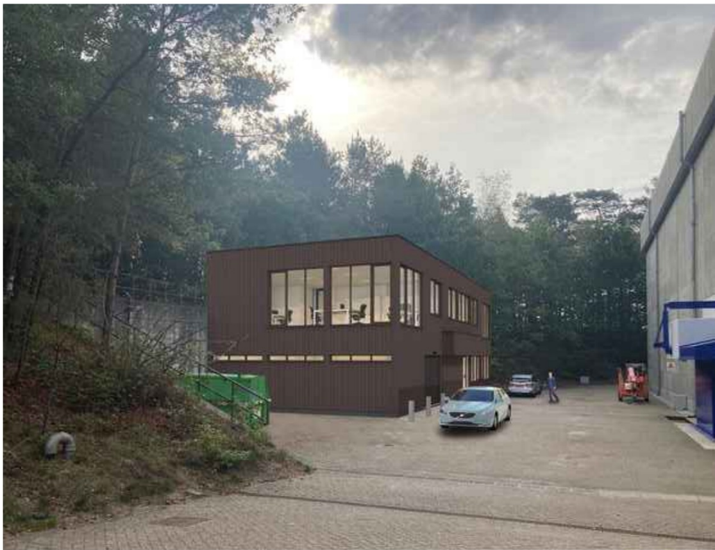
nieuwbouw gezien vanuit noordelijke richting
