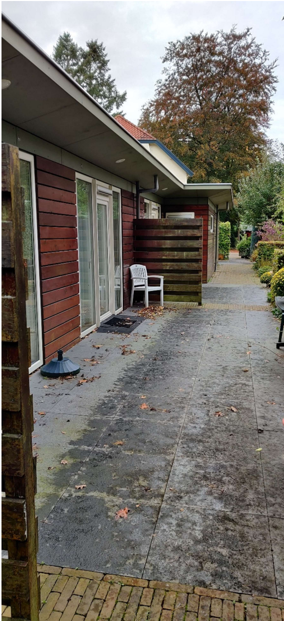
Aanzicht zijkant bestaande aanbouw
