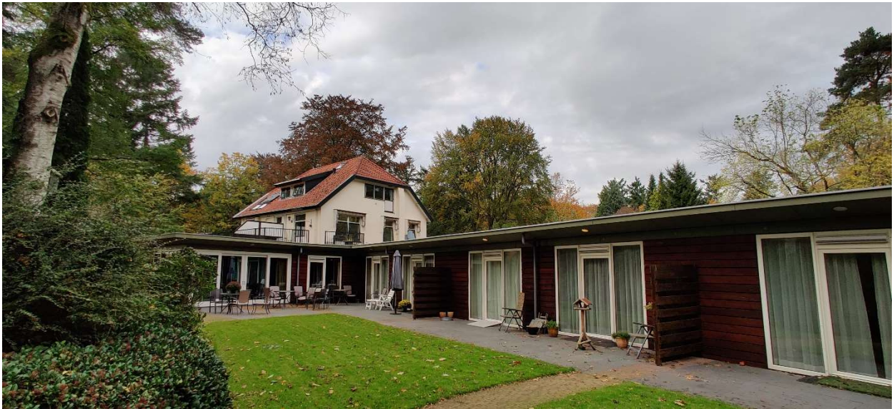
Aanzicht bestaande villa (achterzijde)
