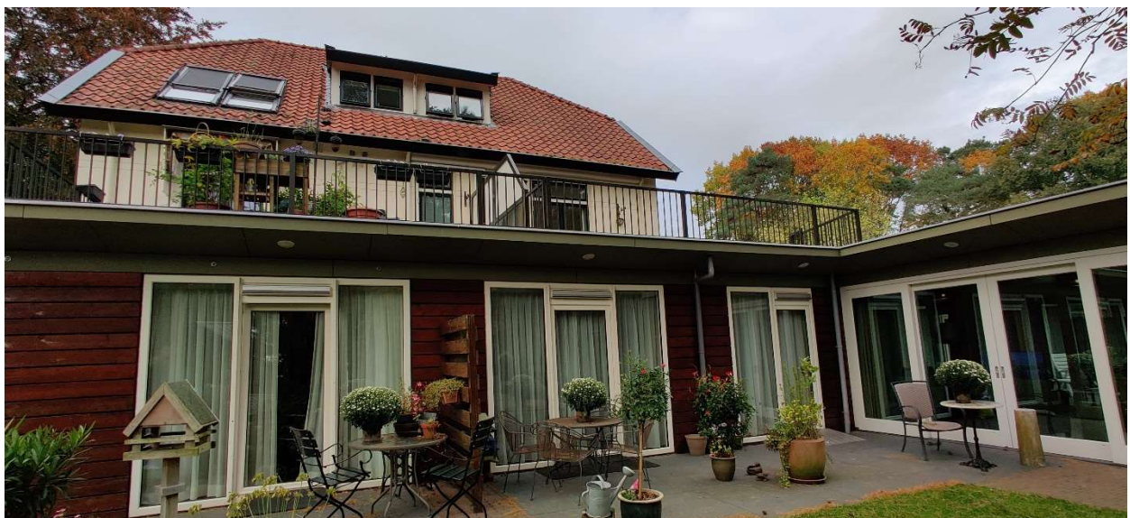
Aanzicht bestaande villa (achterzijde)
