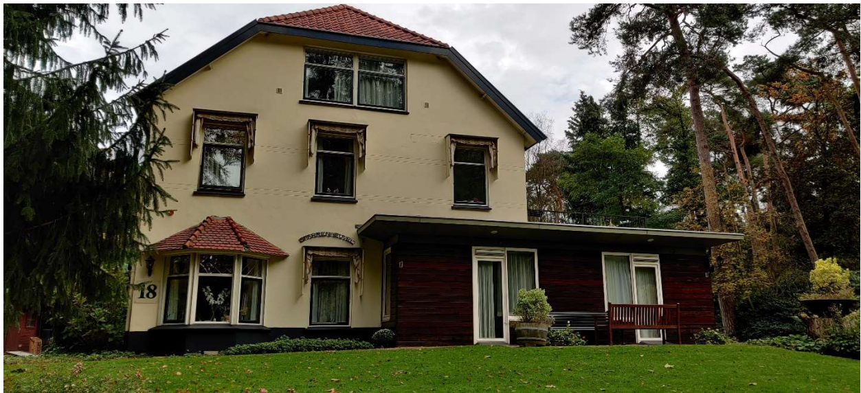
Aanzicht bestaande villa vanaf de Baarnseweg 18
