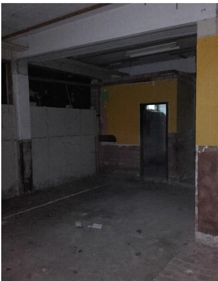
Foto 13. Foto van het deel waar de bowlingbaan gevestigd was. Hier zijn nagenoeg geen kieren en gaten aanwezig.
