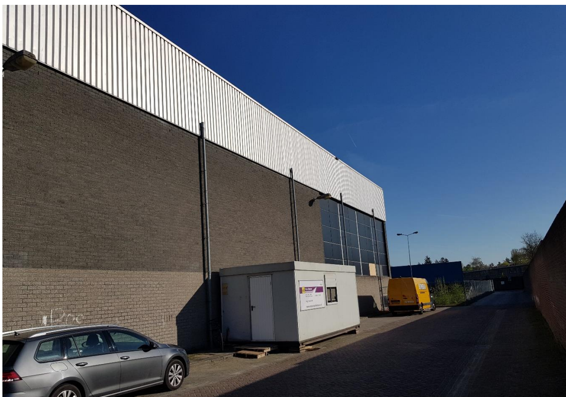
Foto 3. Zuidelijke zijde van het pand, met het pad dat naar de ingang van het terrein van houthandel Van Houwelingen loopt.
