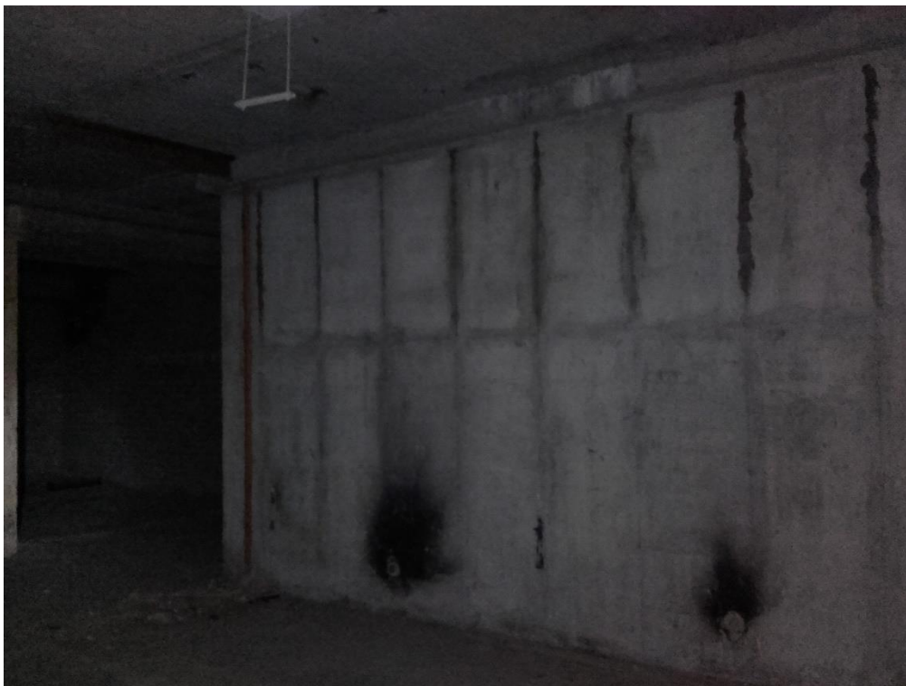
Foto 12. Representatief beeld van het grootste deel van het souterrain: betonnen, gladde muren.
