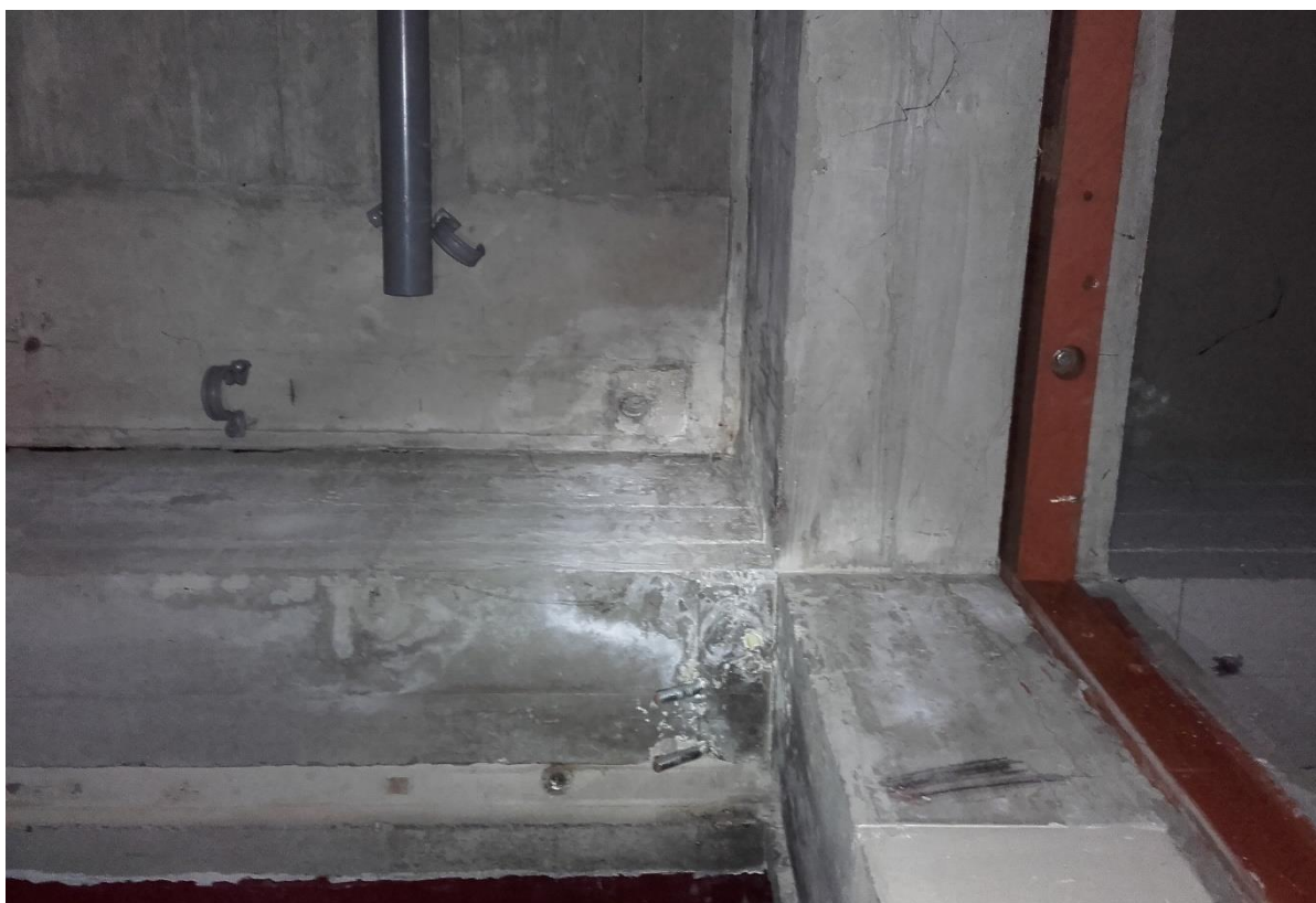
Foto 10. Zicht op het plafond en een doorgang in het souterrain op de locatie waar vroeger de filters etc. van het zwembad stonden
