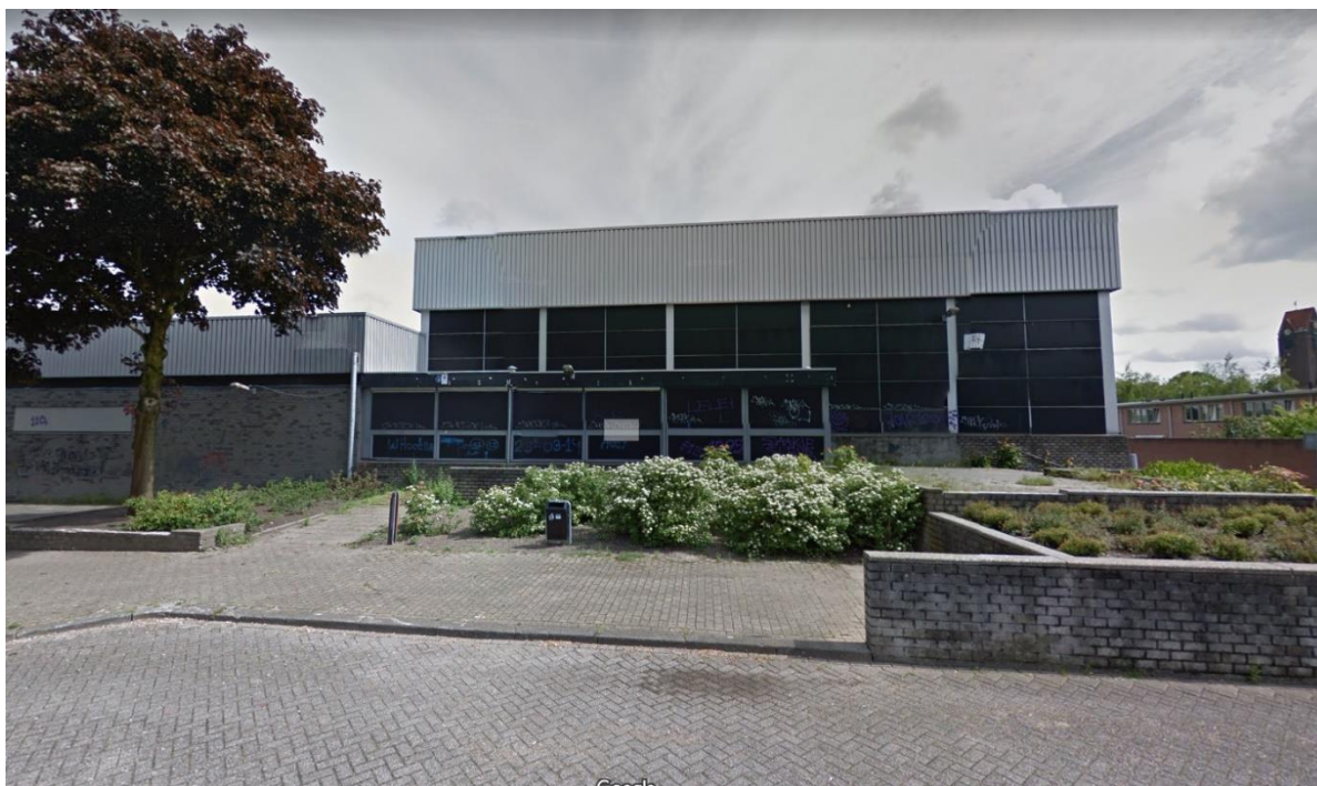
Foto 1: Vooraanzicht van het rechterdeel (zuidoostelijke deel) van het pand. De bloembakken op de voorgrond zijn niet meer aanwezig. (bron: Google)
