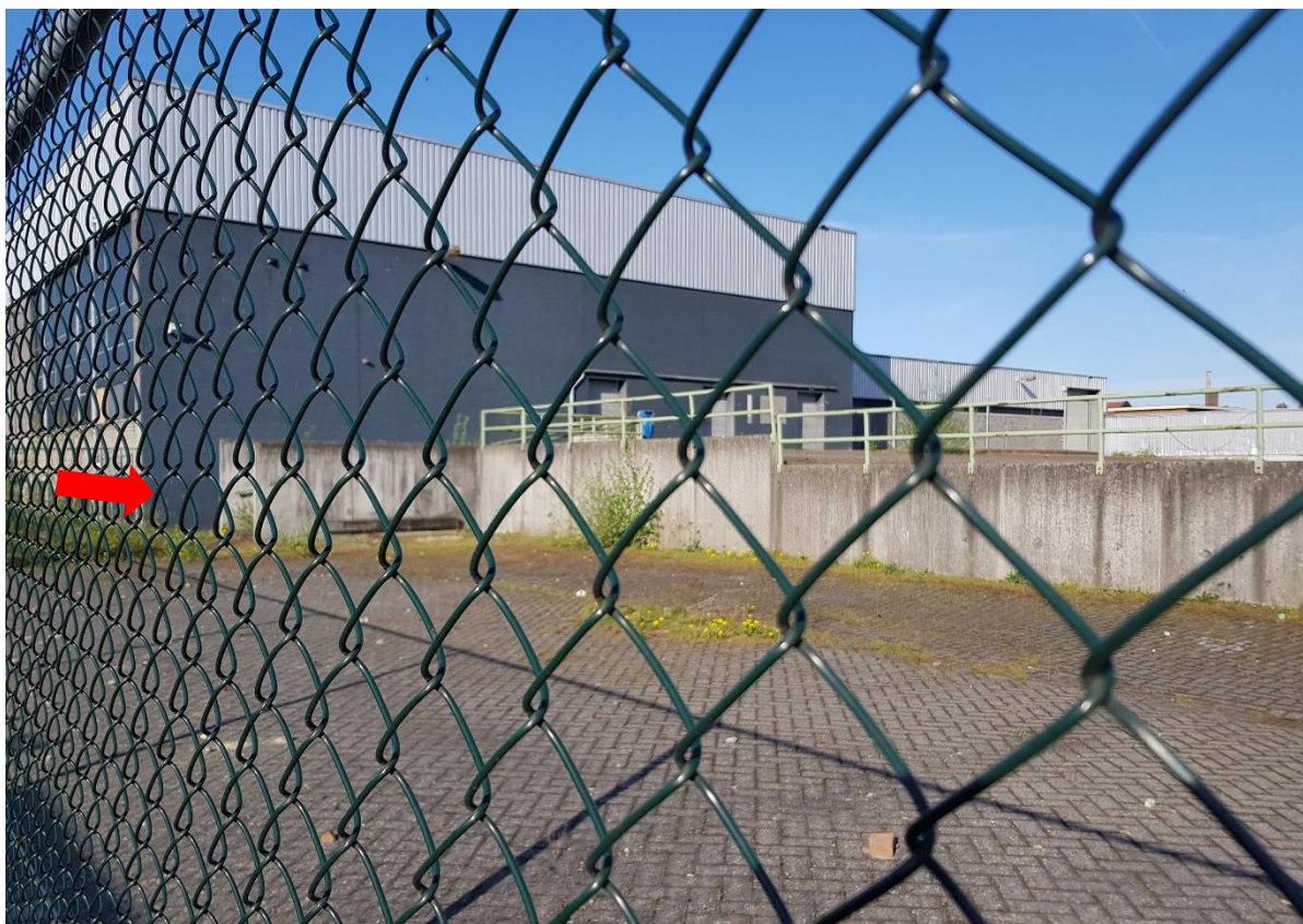
Foto 7. Direct naast het pand bevindt zich, tussen de gevel en de betonnen muur een hellingbaan naar een verdiepte ingang (zie pijl). Tussen de betonnen muren bevindt zich een trap naar het verhoogde deel van het parkeerterrein.
