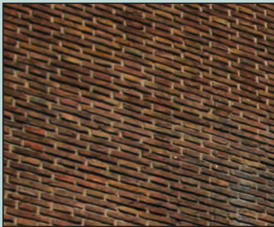
één kleur gemêleerd metselwerk
