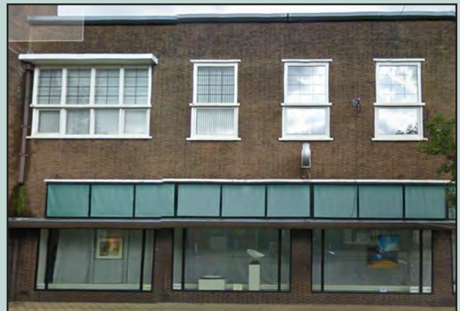
vervangen dakrand / luifel
