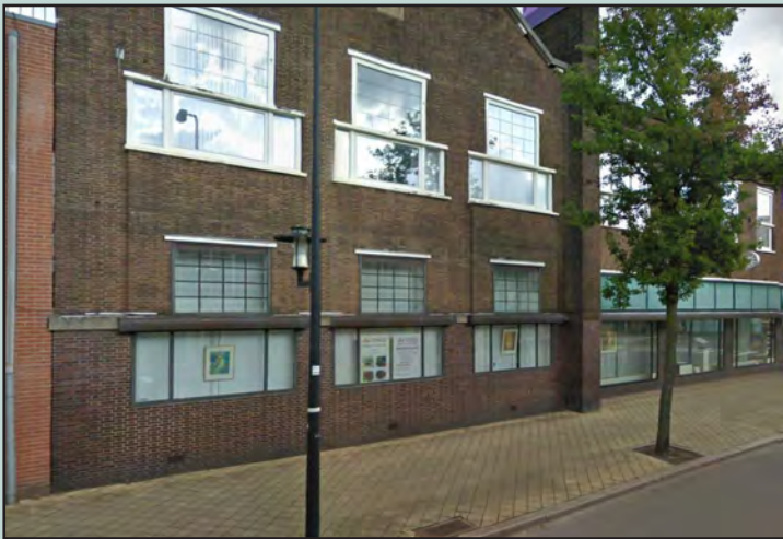
kozijnen hoge borstwering vervangen voor kozijne lage borstwering
