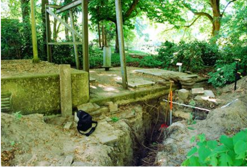
Afbeelding 7 Punt 12 bij betonnen constructie
