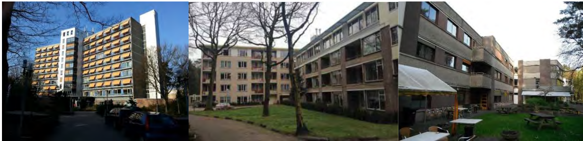
Figuur 3-5. Foto-impressie gebouwen plangebied. Links gebouw 's-Heerewegen, midden gebouw In de Dennen, rechts een deel van gebouw Bovenwegen.
