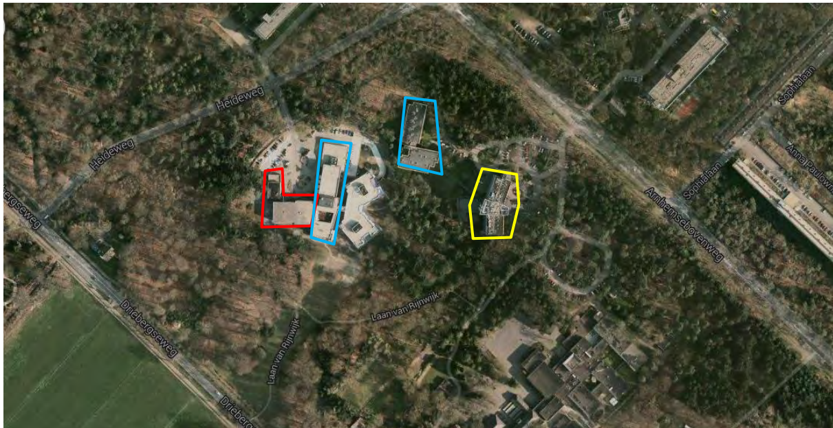
Figuur 5-1. Plangebied met te slopen bouwdeel (rood omlijnd) met zomerverblijfplaatsen gewone en ruige dwergvleermuis en te behouden gebouwen (blauw) die als alternatief kunnen fungeren. In geel het te slopen hoofdgebouw waar geen verblijfplaatsen zijn aangetroffen (bron ondergrond: Google Maps).
