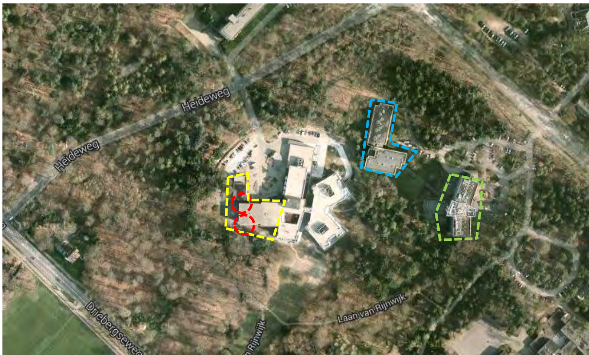
Figuur 4-1. Locaties van verblijfplaatsen van gewone en ruige dwergvleermuis (rood omlijnd). In geel de geschikte delen van gebouw Bovenwegen die gesloopt worden. De overige gebouwen zijn minder geschikt voor vleermuizen en de aanwezigheid van verblijfplaatsen is niet aangetoond. In blauw gebouw 'In de Dennen', in groen 's-Heerewegen'.
