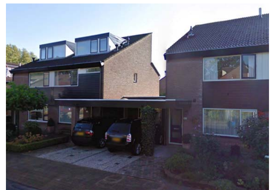
Woningen Brugakker Bron: Google Streetview
