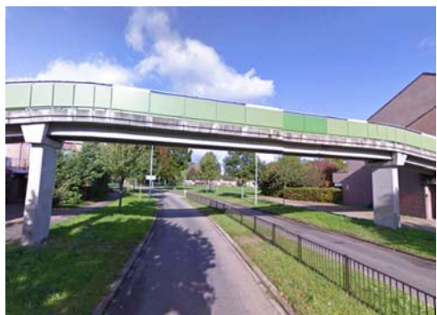
Loopbrug over de Weteringlaan
