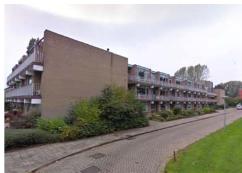
Woonzorggebouw (hoek van de Griftlaan en de Griffensteijnselaan)
