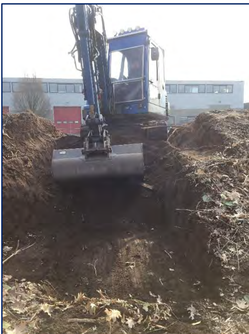
Figuur 4: Gecontroleerd ontgraven.
