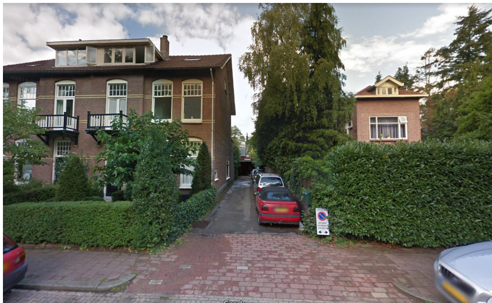
De bestaande in- en uitrit naar de Prof. Lorentzlaan, gelegen tussen de twee-onder-een-kap woning aan de Prof. Lorentzlaan 51 en de vrijstaande woning aan de Prof. Lorentzlaan 53
