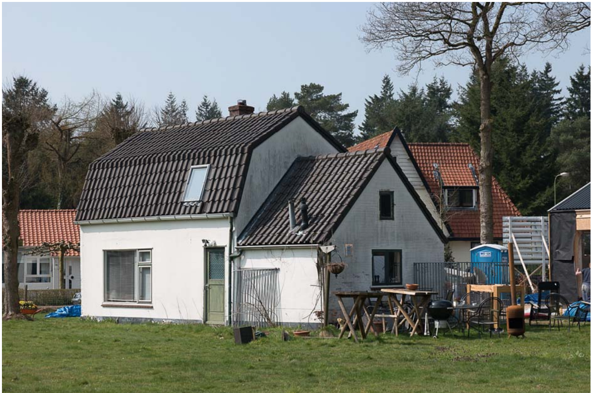
Het te slopen huis met aanbouw, achter het kleine raam zit de zolder
