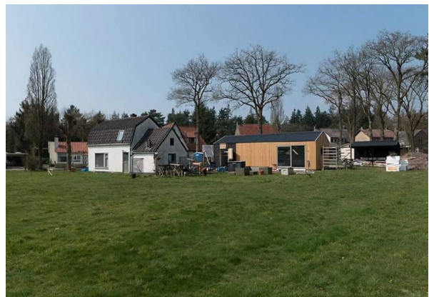
Figuur 8: Het oude huis op de achtergrond met op de voorgrond een deel van het weiland wat behoort tot de EHS. (van de Bijtel 2015)
