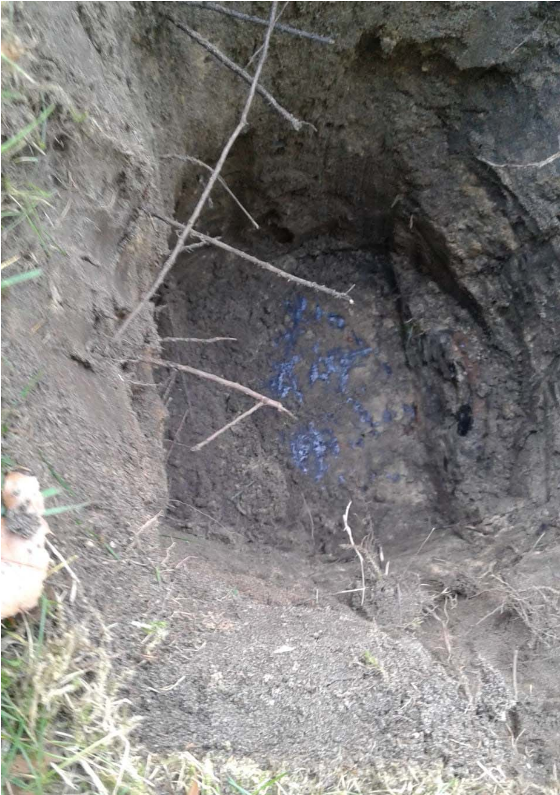
Zelfde locatie: gegraven inspectiegat met zicht op de bovenzijde van de tank
