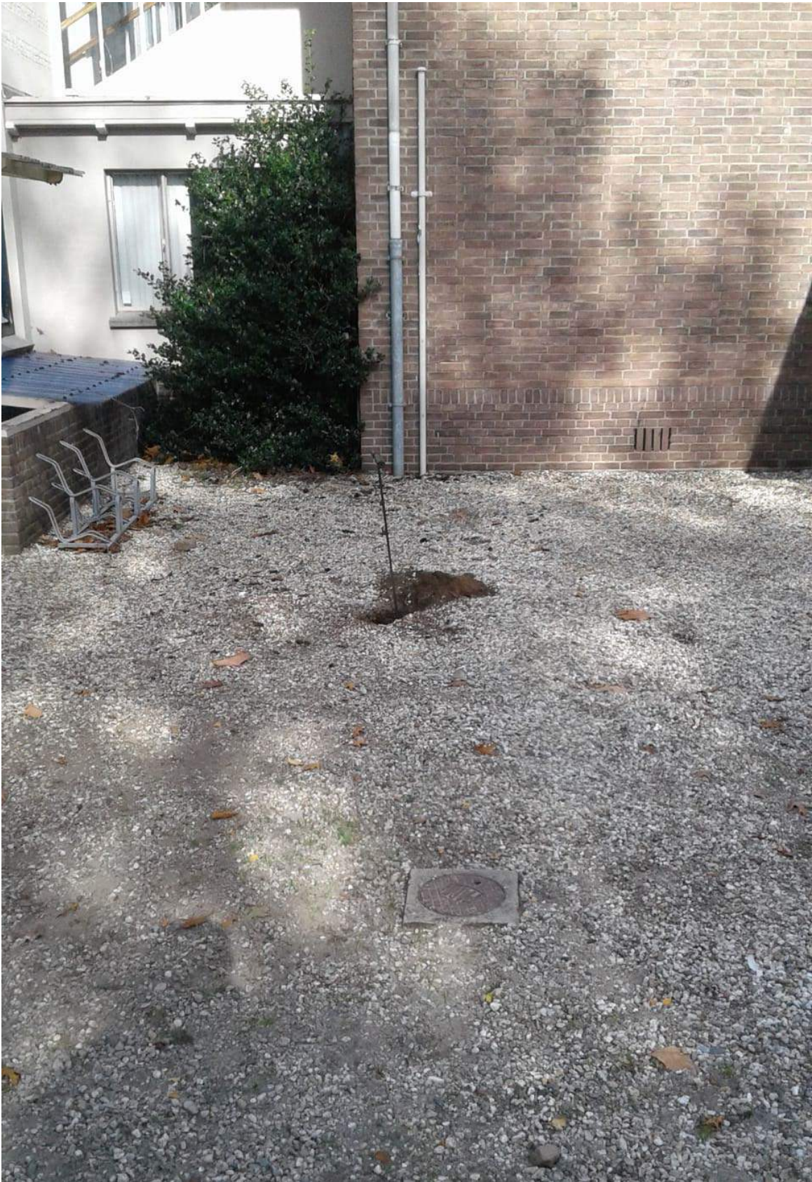
Zuidgevel hoofdgebouw met zicht op ontluuchtingspijp behorende bij een ondergrondse olietank
