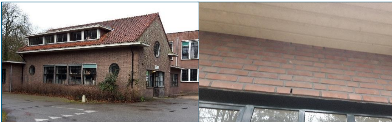
Figuur 4-3: overzichtsfoto van gebouw 22 (Linnengebouw). Foto: Royal HaskoningDHV, 2020.
