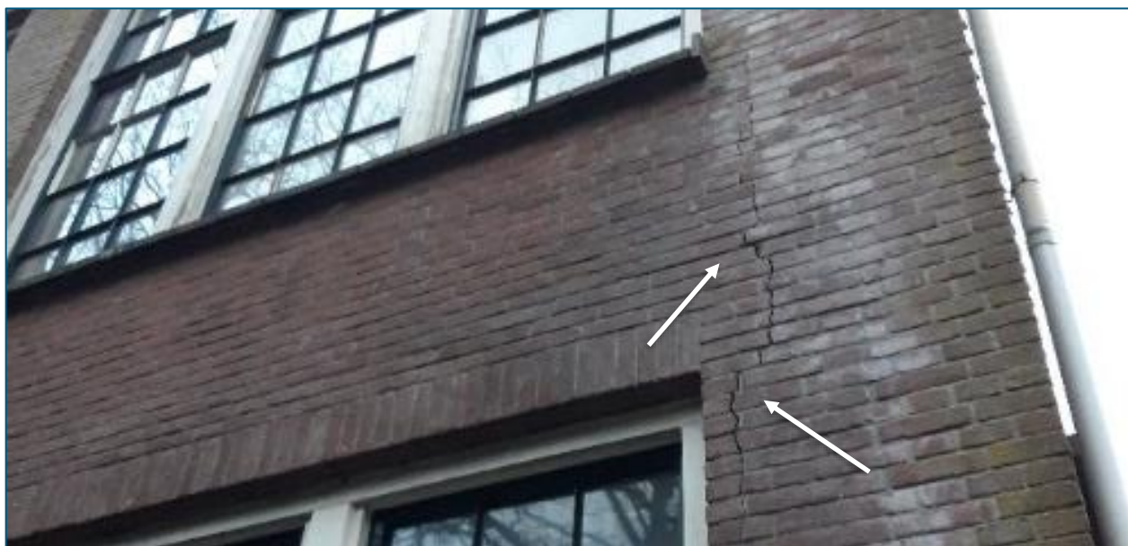
Figuur 4-5: detailfoto van de achtergevel van gebouw 24 (Bedrijfsgebouw). Foto: Royal HaskoningDHV, 2020.
