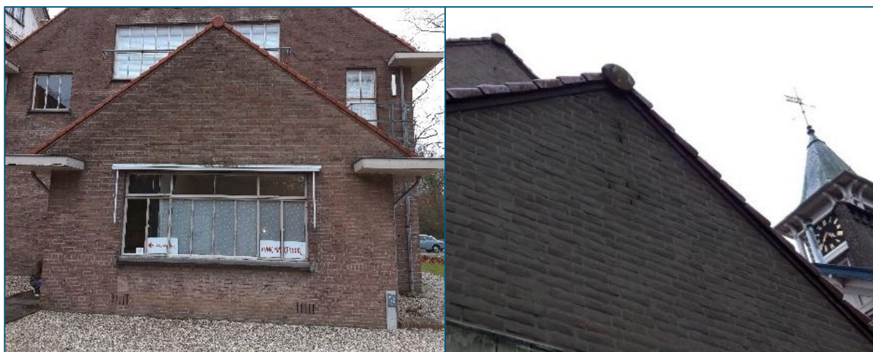
Figuur 4-6: overzichtsfoto van de deelsloop van het hoofdgebouw (links) en een impressie van de aanwezige luchtgaten en dakrand van de deelsloop (rechts) Foto: Royal HaskoningDHV, 2020.
