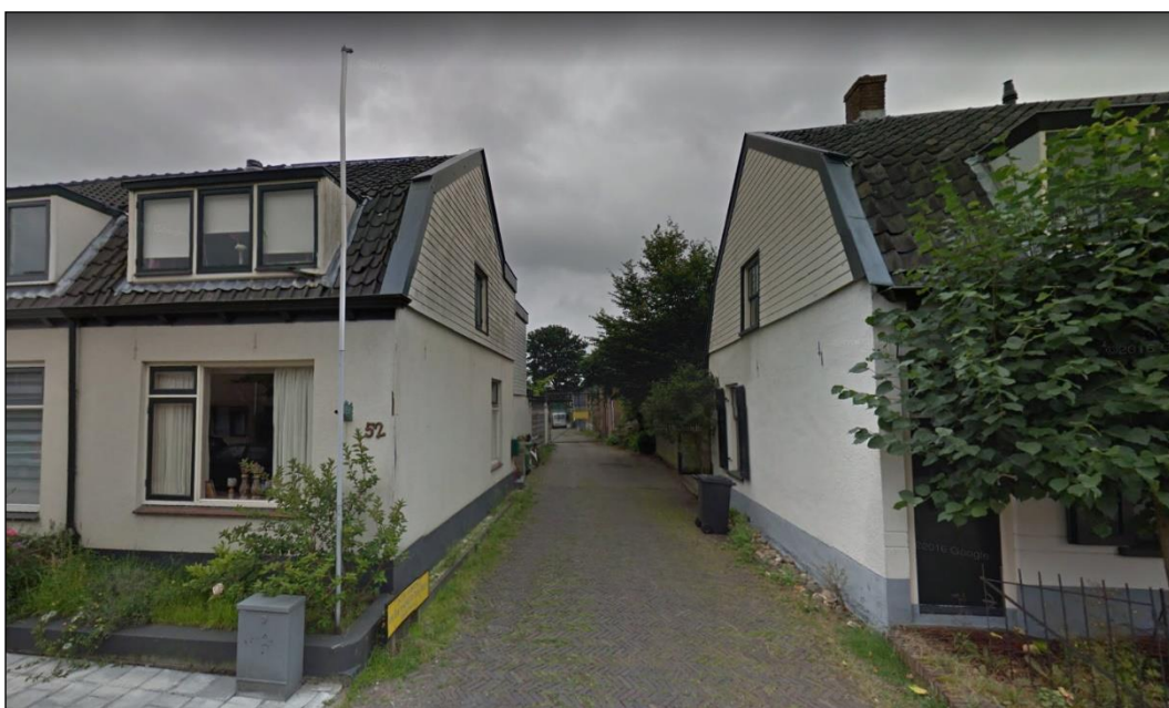
Figuur 6: Entree plangebied aan de zijde van de Van Reenenweg (bron: Google Streetview)
