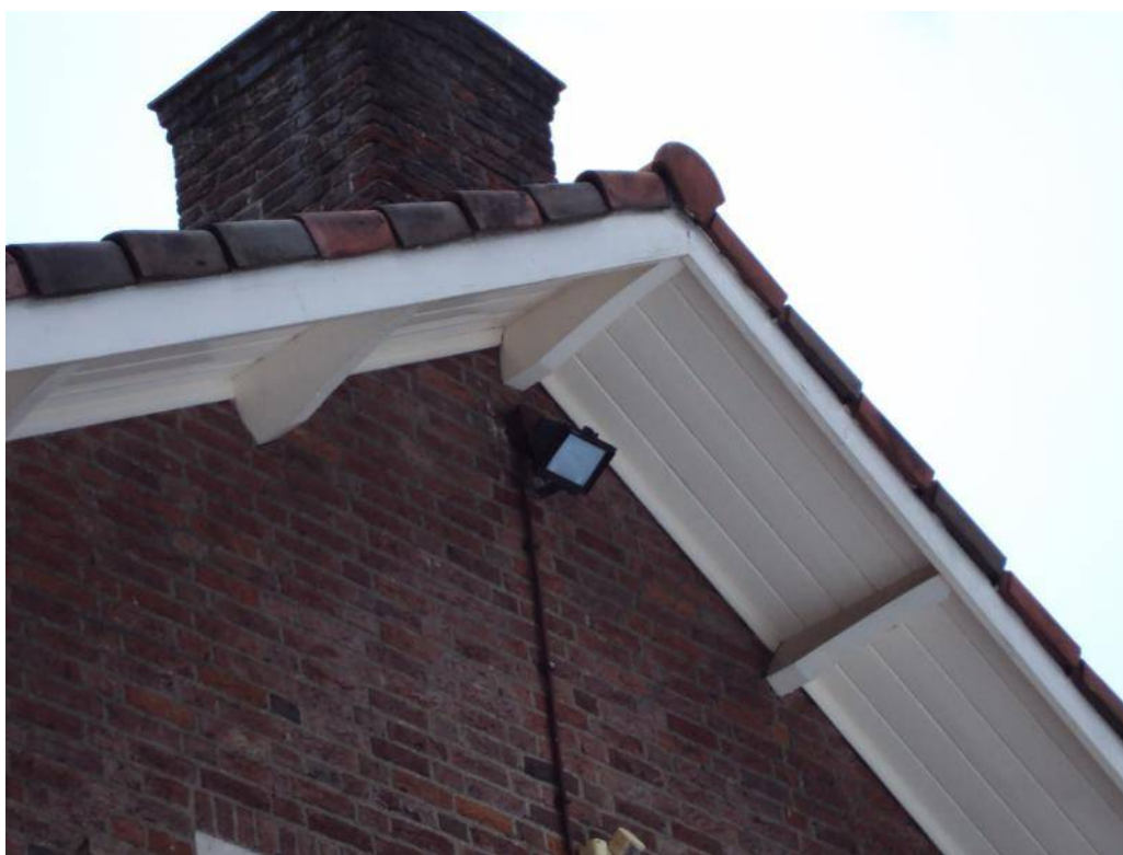
Foto 3. Onder de dakpannen is ruimte aanwezig waar vleermuizen kunnen verblijven.
