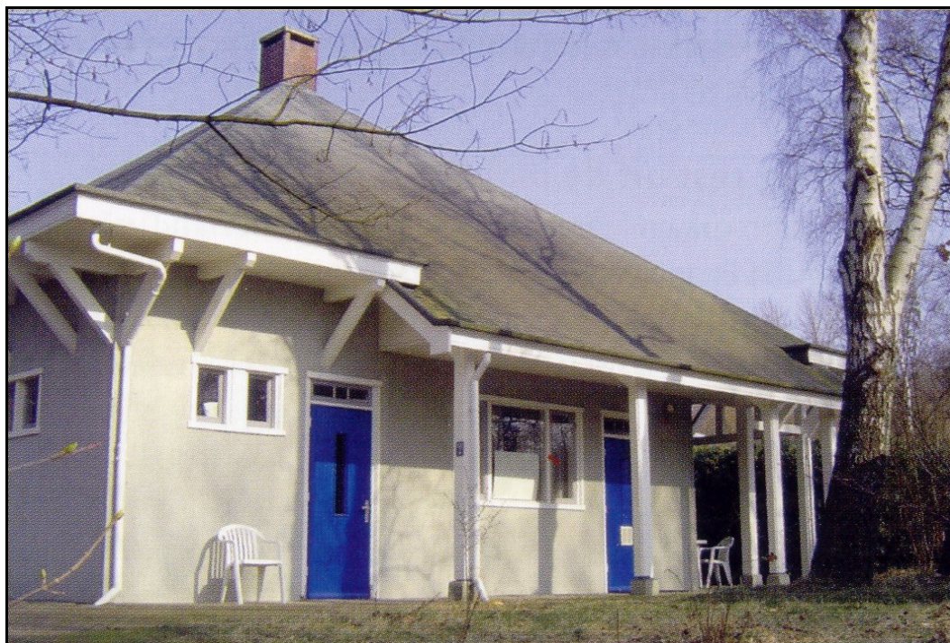
Figuur 3.17: Een kantoorgebouw uit de periode 1910-1911. Het gebouw overleefde de Tweede Wereldoorlog en is mogelijk het oudste luchtvaartgebouw van Nederland (Volkers 2006). Voor een meer gedetailleerde studie en weergave van de gebouwen en structuren verwijzen wij naar de studie van Bureau voor Bouwhistorie en Architectuurgeschiedenis (Stenvert 2007, in voorbereiding).
