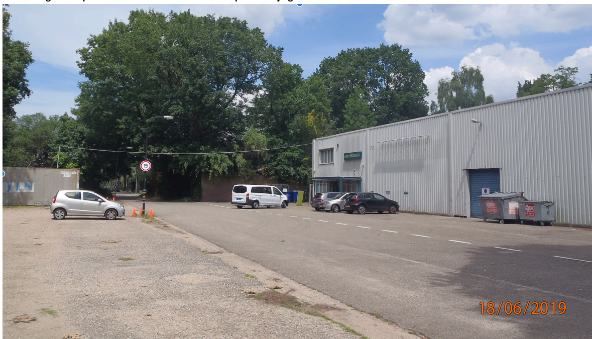
Afbeelding 7: Het parkeerterrein en rechts het te slopen bedrijfsgebouw met kantoor
