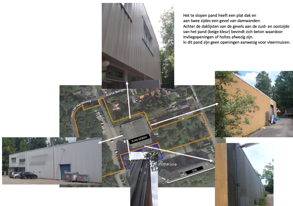
Afbeelding 10. Het te slopen gebouw
