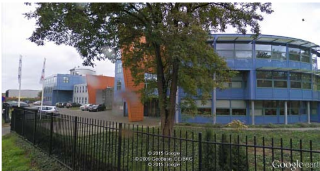
Bedrijventerrein Fornhese (bron: Google Streetview)
